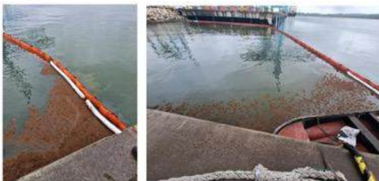
Imagen 1: Barreras de contención en sitio y uso de musgo absorbente para contener hidrocarburos.
