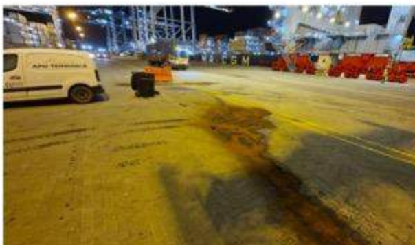
Imagen 3. Evidencia de la limpieza del derrame.
