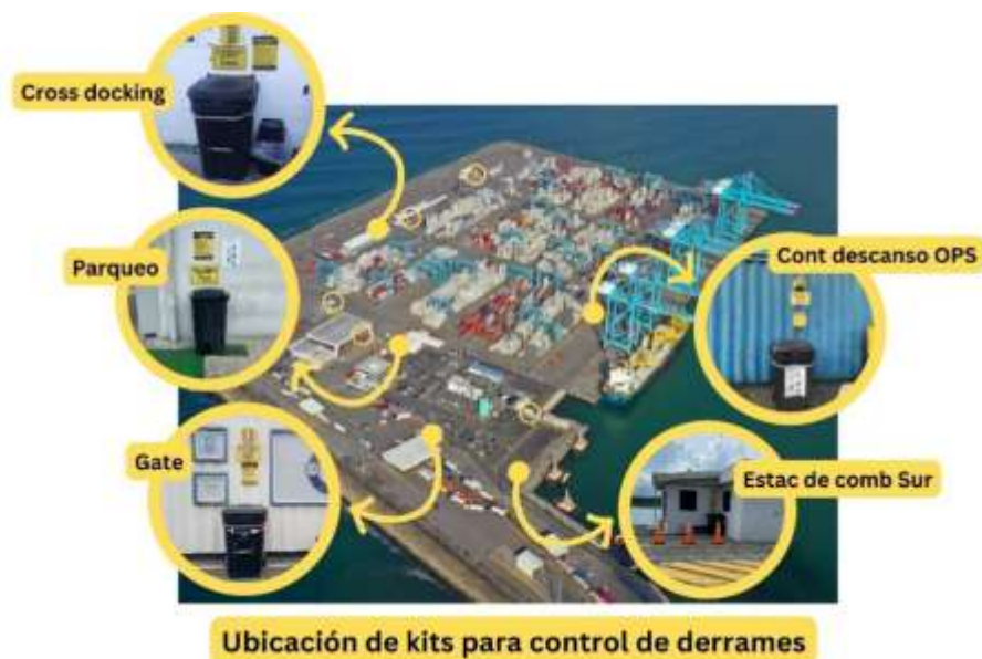
Figura 8: Ubicación de kits para el control de derrames, parte 2.
