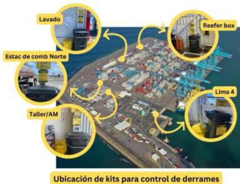
Figura 7: Ubicación de kits para el control de derrames, parte 1.
