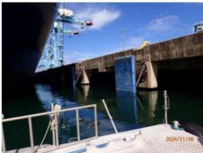
Fotografía 1. Muelle de TCM, Pilotes y defensas.
